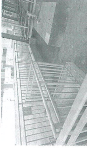
提取精制车间内中间储罐区围堰
